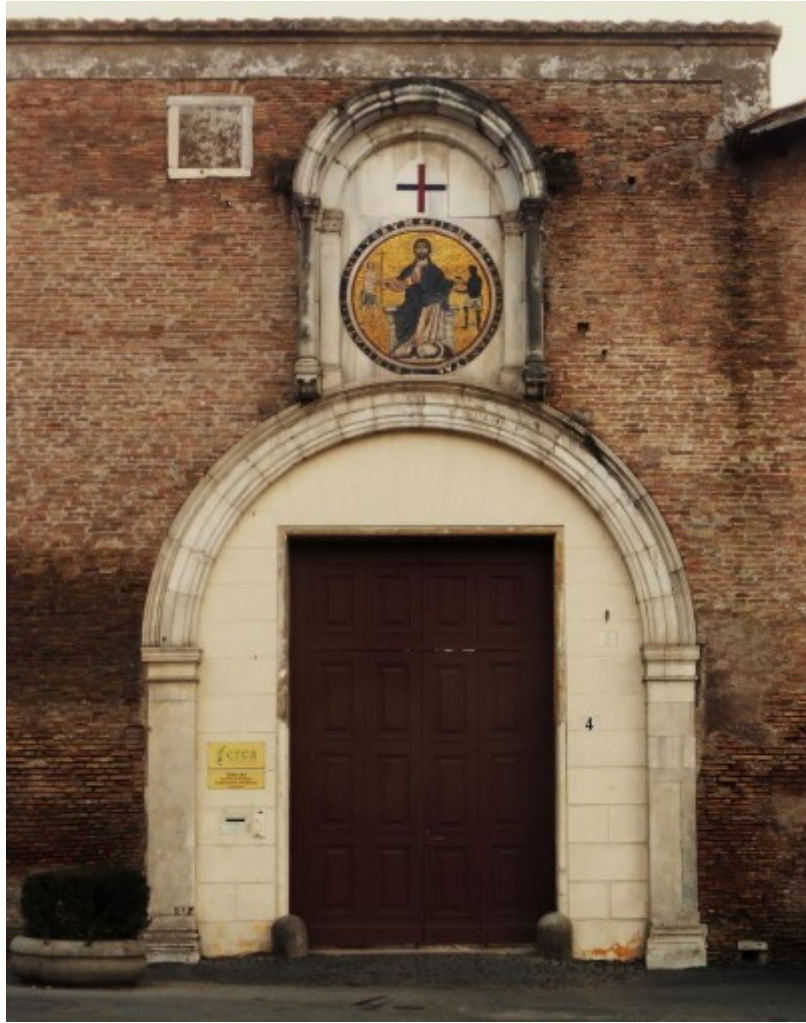
Roma, San Tommaso in Formis , portale di accesso all'ospedale.
